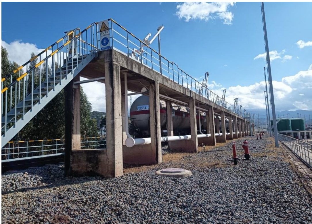
图 2-3 航煤卸油栈桥
