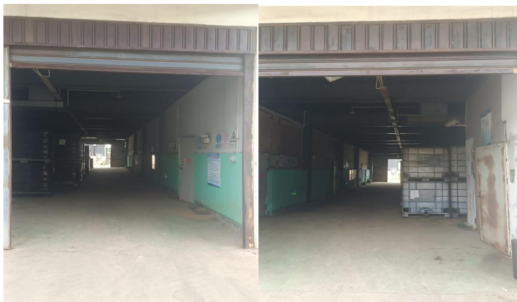
乙类仓库一层区域（存放遇水燃烧物品一级及遇水燃烧物品二级）
